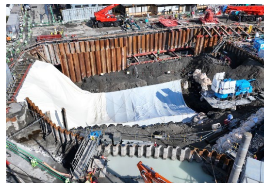
現場状況(3月17日撮影)
