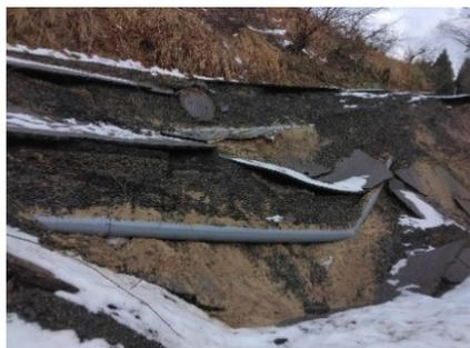
浄水場から配水池へ向かう水道管の破損・露出 (輪島市)
