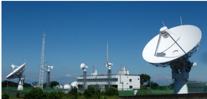
宇宙電波監視施設（神奈川県三浦市）
