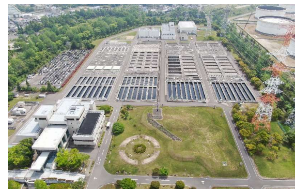
仙塩浄化センター
