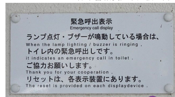
▼非常警報装置案内板の例
