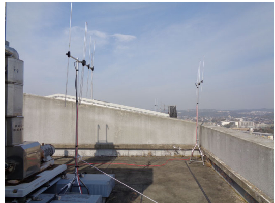
図7-4 実験局アンテナ設置状況
