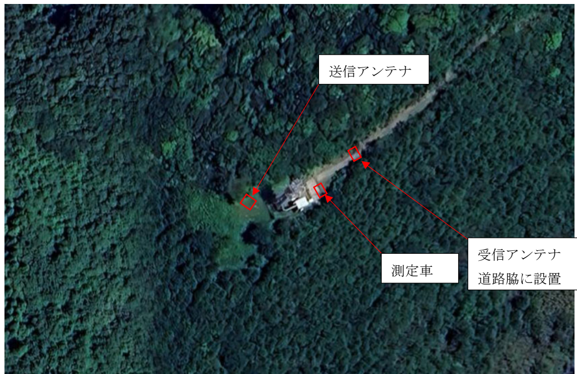
図5-30 雨乞岳実験局の設備設置場所
