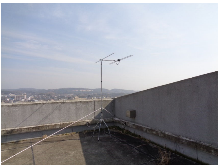
図 5 - 4 8 総合研究棟（実験局 B） 送信空中線 設置状況
