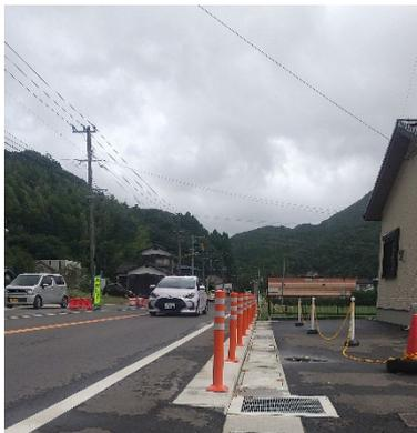
段差箇所にラバーポールが設置されたことで、段差への接近が防止されるようになっています。
