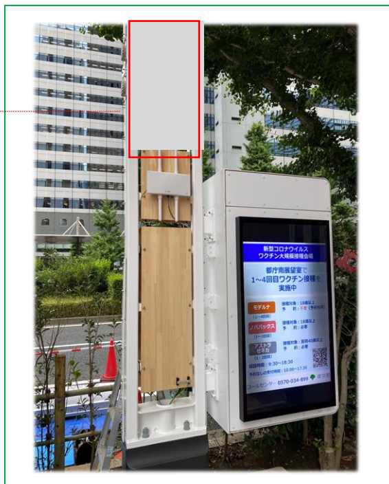
スマートポール内部構造
