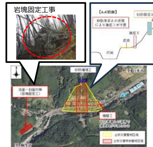
砂防事業と連携した法面对策 (栃木県日光市)
