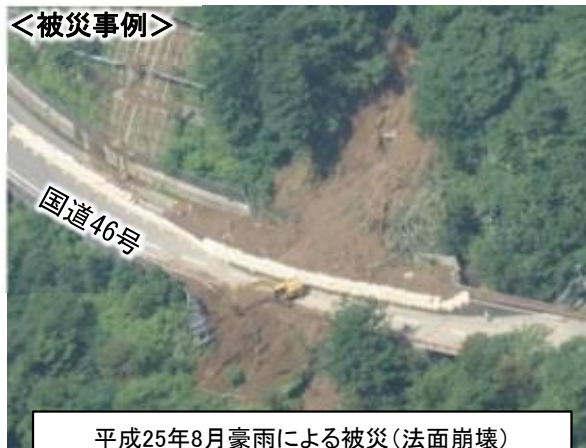
平成25年8月豪雨による被災(法面崩壊)
