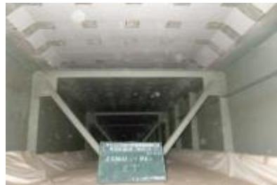
炭素繊維シートの貼り付け
