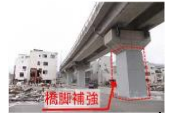
耐震補強例（金石高架橋）
