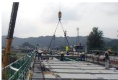
プレキャスト床版による 打ち替え
