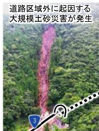
令和2年7月豪雨 (14日間の通行止め)
