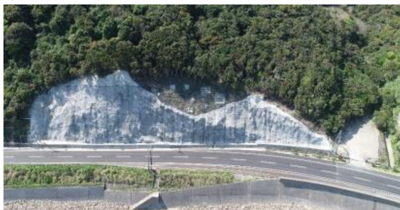
法面吹付工、落石防止網工
