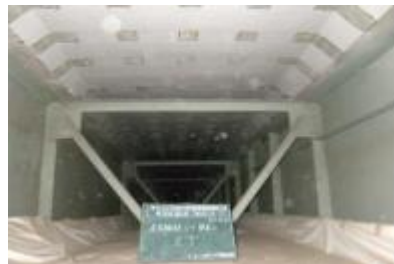
炭素繊維シートの貼り付け
