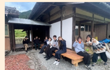
空き家の改修
