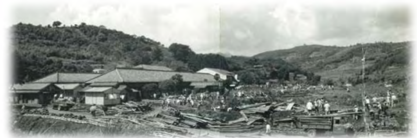
（7.8災害により被害を受けた大浦小学校）
