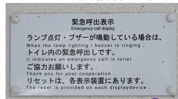
▼非常警報装置案内板の例
