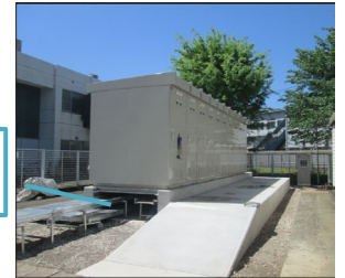
調布分室の更新された高圧変電設備 <特高→高圧へのダウンサイズ、点検省人/省力化>
