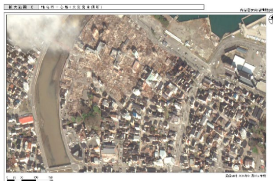
火災発生箇所
