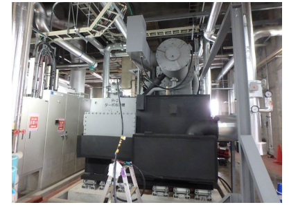
筑波で更新したターボ冷凍機600RT <冷凍機のダウンサイジング(20%減)>
