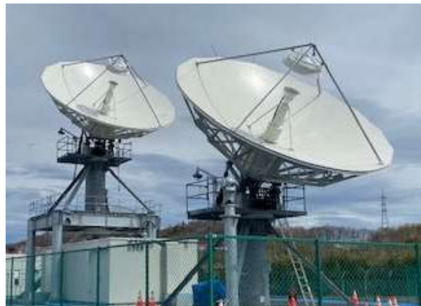
C帯/Ku帯監視施設 （茨城県常陸大宮市）
