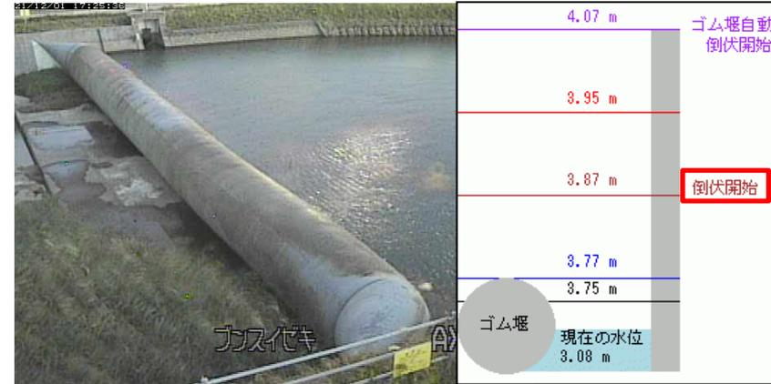
分水堰水位の常時監視と気象・雨量情報を基に、堰倒伏開始水位に至るまでの時間を職員が推定し、操作手続きと行動を実施
