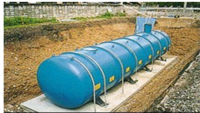
【耐震性貯水槽】
