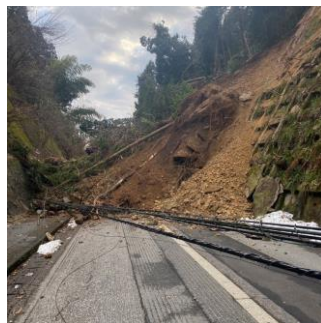
ケーブルの断線・土砂災害・中継局の倒壊による被害
