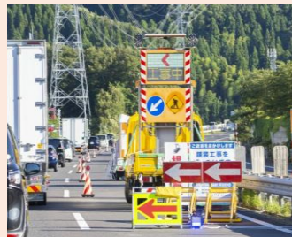
道路工事区域
