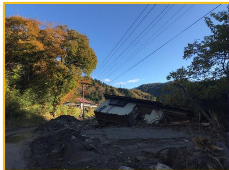
【土砂と水の力で流された家屋】
