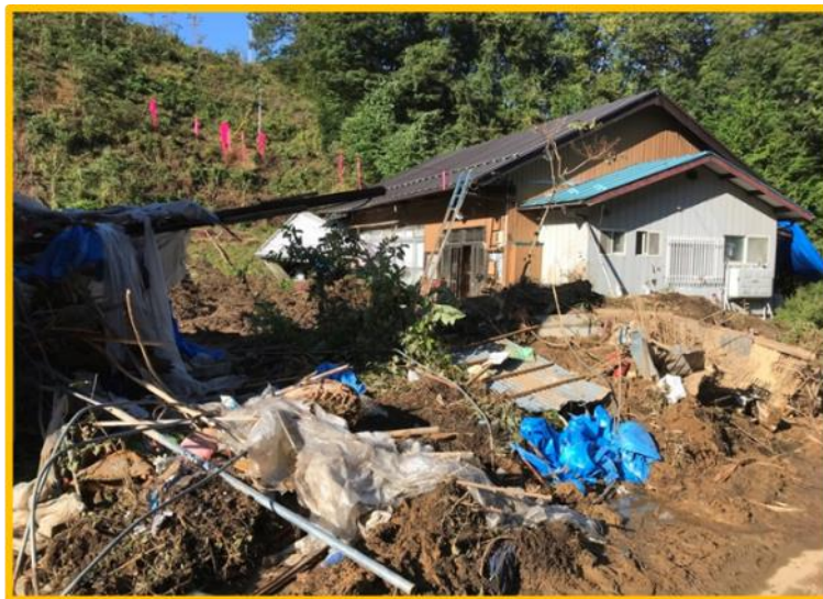
【土砂崩れで家屋内に土砂流入】
