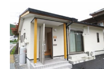
空き家の改修（お試し居住施設）
