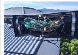
局外収容装置老朽化の事例 (RT-BOXサビ、倒木等)
