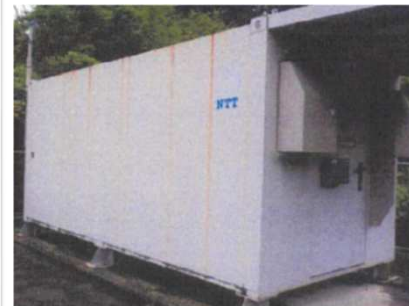
局外収容装置老朽化の事例 (RT-BOXサビ、倒木等)
