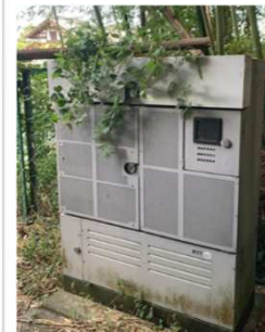
局外収容装置老朽化の事例 (RT-BOXサビ、倒木等)
