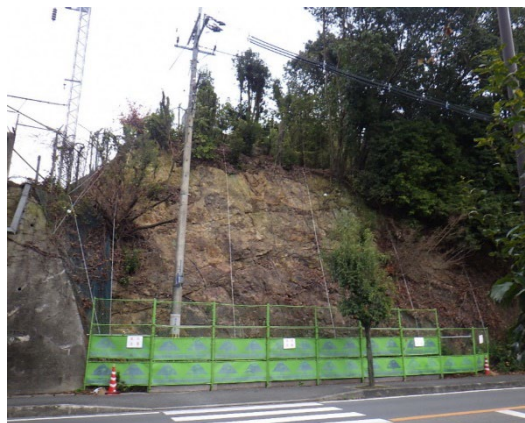
法面防護：施工前
