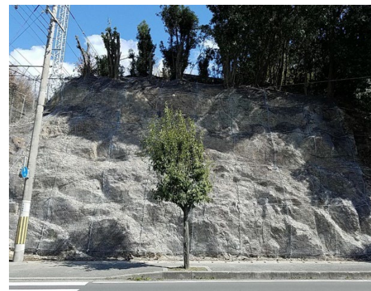
法面防護：施工後
