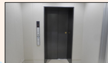
エレベーター (新設)
