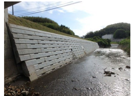
護岸整備：施工後
