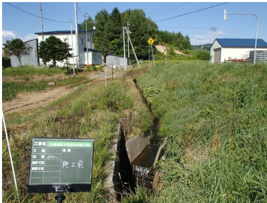
水路整備：施工前
