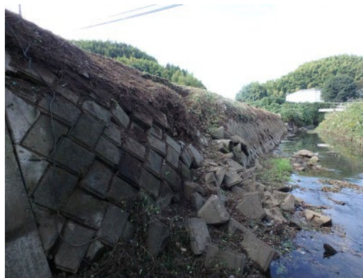
護岸整備：施工前
