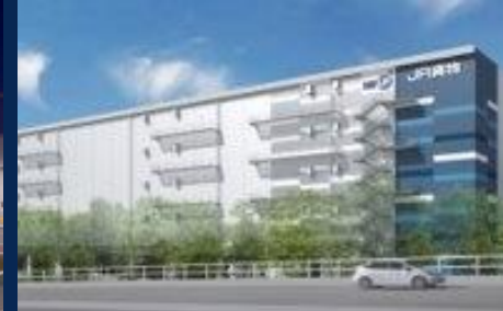
例）JR貨物東京レールゲート
