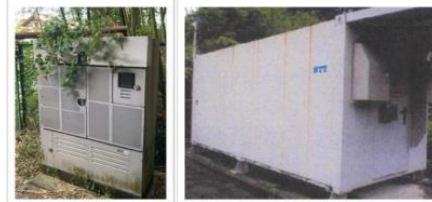
局外収容装置老朽化の事例 (RT-BOXサビ、倒木等)
