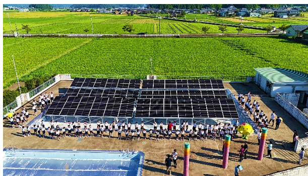
現役小学校のプールに設置された太陽光パネル
