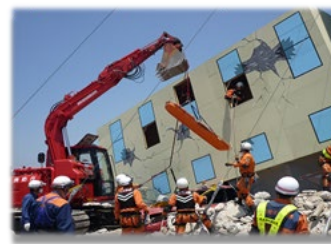
倒壊建物からの救出
