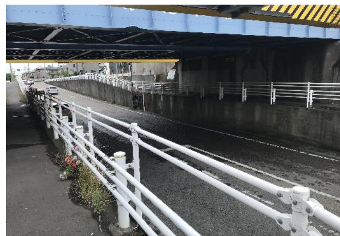
高架橋の下をくぐるアンダーパス
