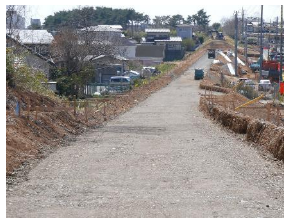
鉄道の廃線跡地に専用道路を敷設*1
