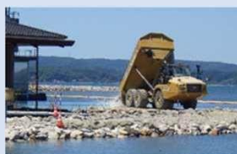
護岸復旧のための仮設道路整備（和倉港）
