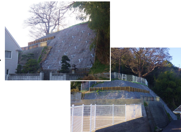
急傾斜地法面对策：施工後
