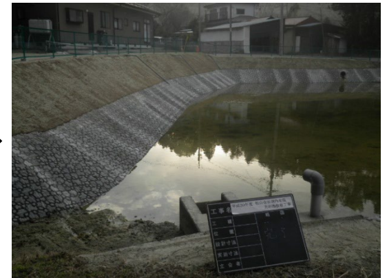
ため池堤体整備：施工後
