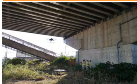
ドローンを活用した点検作業の様子
