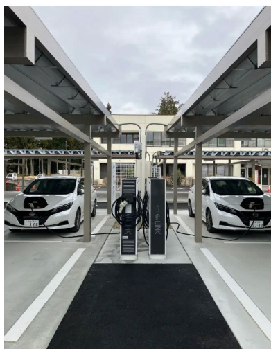
整備が進む太陽光発電設備（左）、ソーラーカーポートV2X双方向充電器（右） 出典： https://prt-times.jp/main/html/rd/p/000000015.000036744.html
