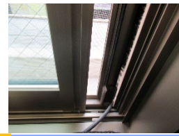
アンテナケーブルを 窓から引き込み
