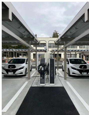
整備が進む太陽光発電設備（左）、ソーラーカーポートV2X双方向充電器（右）
