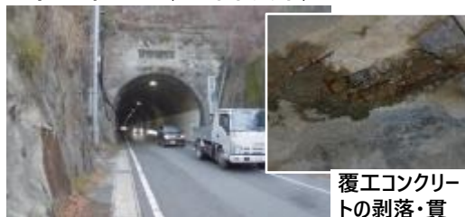
<仁方隧道の状況>
