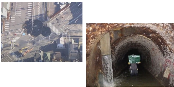
化学的弱部(腐食のおそれ大きい箇所)における事例
