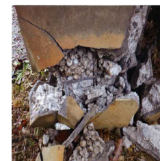
能登半島地震での局舎基礎部分の損壊例
