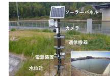
農業用ため池の水位を把握するための遠隔監視機器
