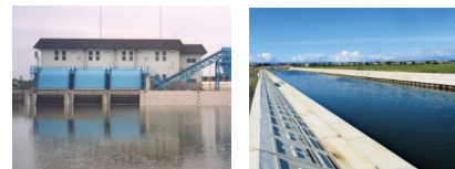
排水機場、排水路の整備
