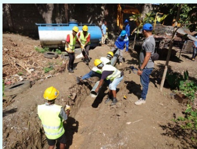
〈配水管工事の指導〉
