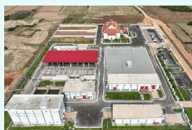
<写真右> シェムリアップ上水道拡張事業
