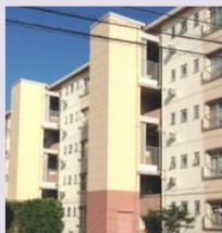
中層住棟への エレベーター設置
