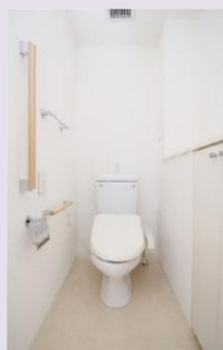
住戸内への 手すりの設置
