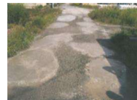
農道の窪みの補修
