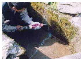
水路のひび割れ補修
