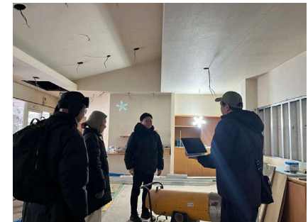
現場確認の様子
