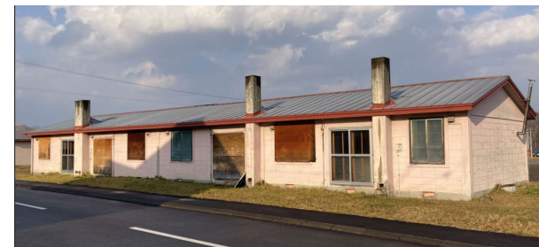
平屋建て公営住宅
