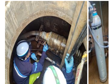
④ ガス漏洩探索・ガスボンベ交換
