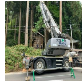
① 車両等被害によるケーブル復旧
