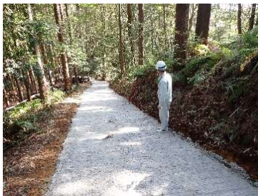
（コンクリート路面工）
