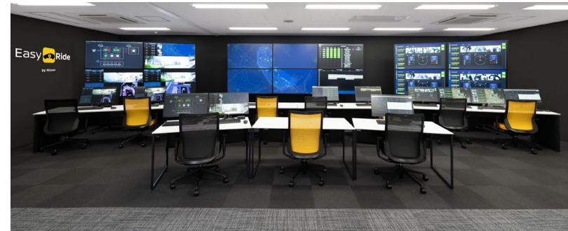
(日産の遠隔監視センター)
