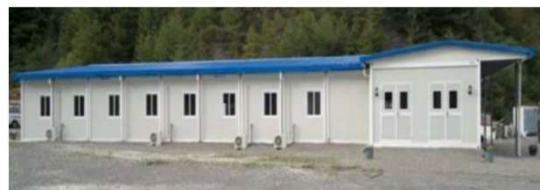
フラットパックコンテナ（岩手県立大槌病院）
