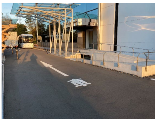
図付 1-3-1 車両前方 30 m 位置までの周囲状況(手前手すり端部位置が 30 m)
