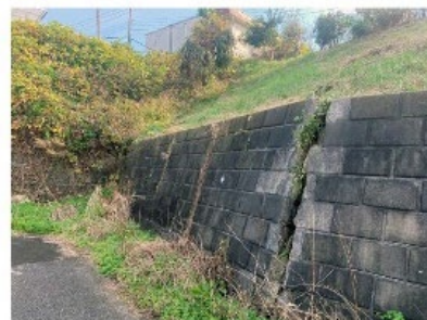
のり面のハラミ 擁壁のズレ
