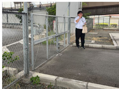
緊急開口部現地確認
