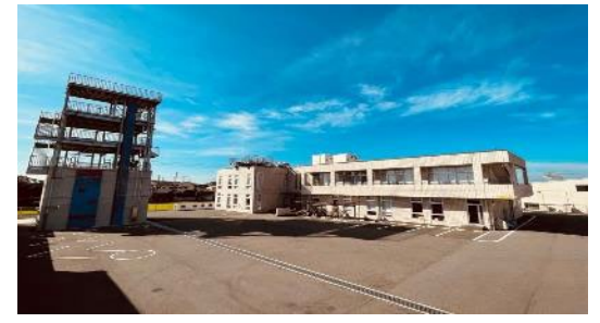
消防署・訓練施設（奈良県広域消防組合）
