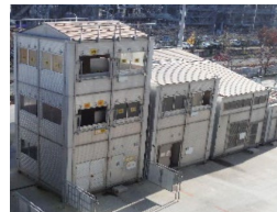
「街区火災対策訓練施設」
