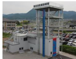
「高所訓練施設」
